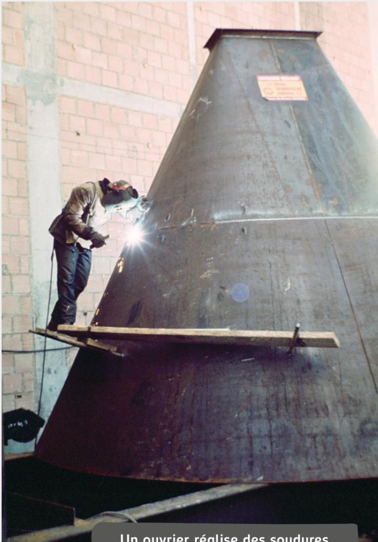
Un ouvrier réalise des soudures sur un silo à drèches (avril 1968)
